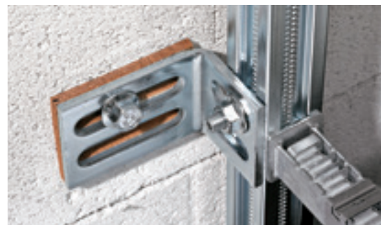
↑ De Geberit GIS montagehoek met geluidsisolatieplaat van kurk garandeert een stabiele verankering van het draagsysteem en betrouwbare geluidsisolatie.
